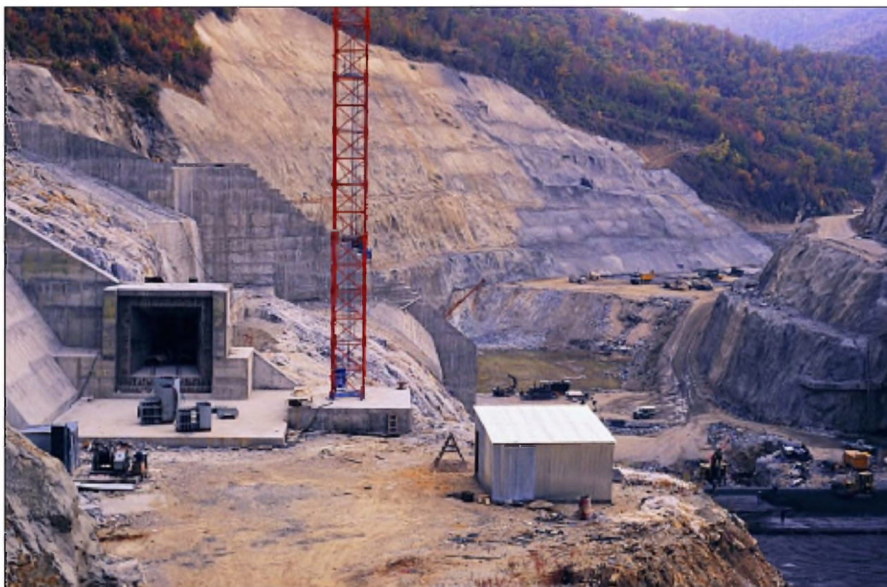
Κατασκευή φραγμάτων της ΔΕΗ στην περιοχή του Νέστου Φωτ. Αρχείο ΕΚΒΥ
