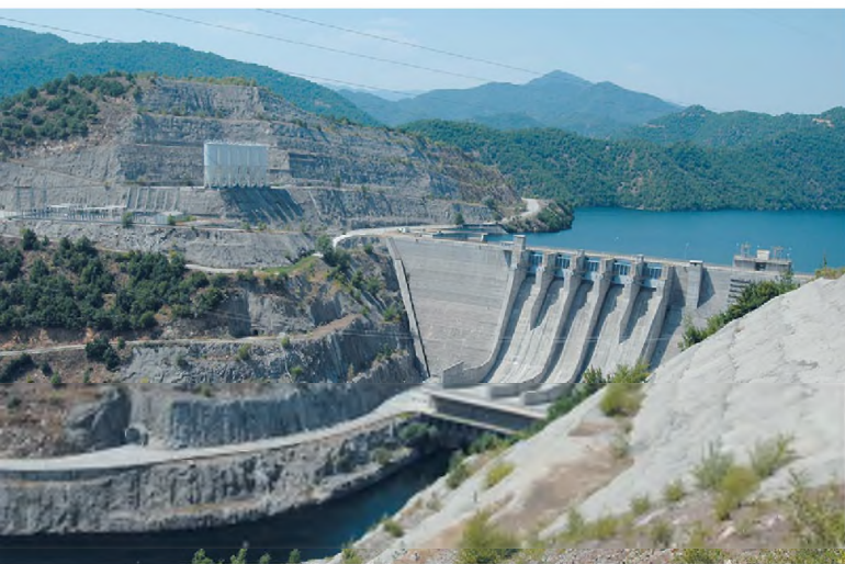
Φράγμα Πλατανόβρυσης στον ποταμό Νέστο, Φωτ. Αρχείο ΕΚΒΥ/Εγχρωμον
