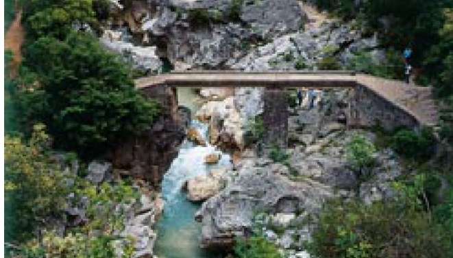
Παραδοσιακό γεφύρι, Φωτ. Αρχείο ΕΚΒΥ / Έγχρωμον
